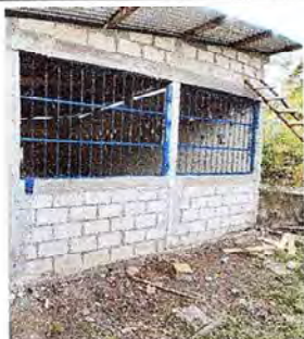
Foto 3: Se instalo balcones de preprimaria, dos balcones la medida es 2.25x 1.50 mts.
