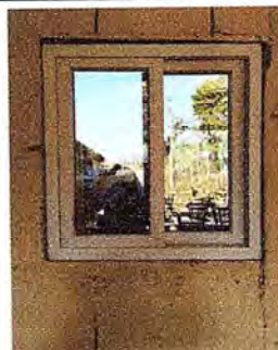
Foto 4: fue colocado la ventana de preprimaria, la medición es 86 x 2 mts.
