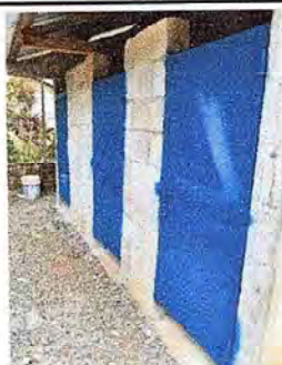
Foto 5: Se instalo tres puerta de letrino de lado derecho.
