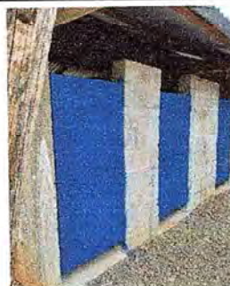
Foto 6: Se instalo tres puerta de letrino de lado izquierda.
