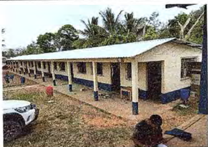
Foto1: fue cambiado el techo de la escuela formal la medición es de largo 43 mts. Y el anch es 9 mts.
