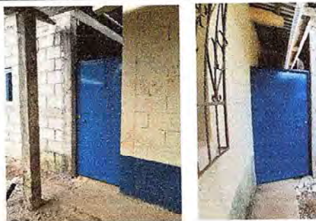
Foto 2: fue instalado de las dos puertas con la medida es 86x 2 mts.
